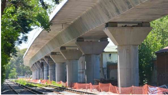
Figura 2: Viaducto de hormigón armado.
