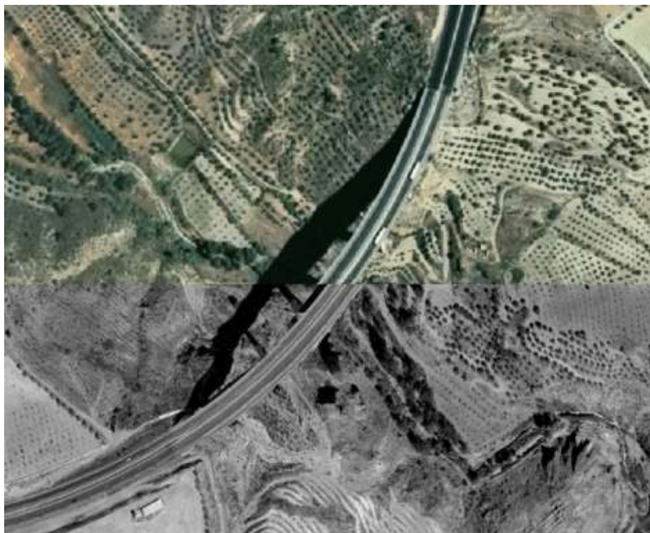
Fig. 7. Ejemplo de incidencia. Falta de coincidencia en viaducto con la ortofotografía de referencia.
