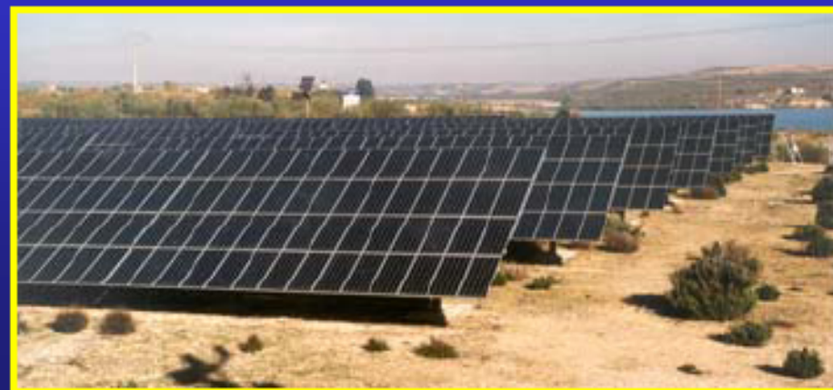
Campo de paneles FV
