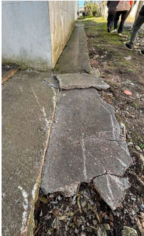
Figura 7: Levantamiento de la vereda perimetral - Lateral Bóveda D
