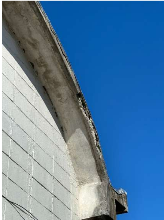
Figura 4: Bóveda - Parte posterior Bóveda D
