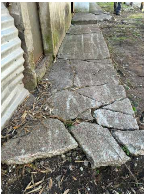
Figura 6: Levantamiento de la vereda perimetral - Anexo a Bóveda D
