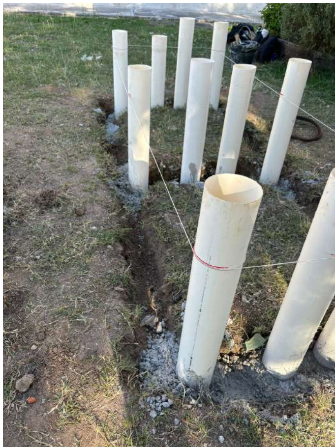
Figura 14: Nivelado
