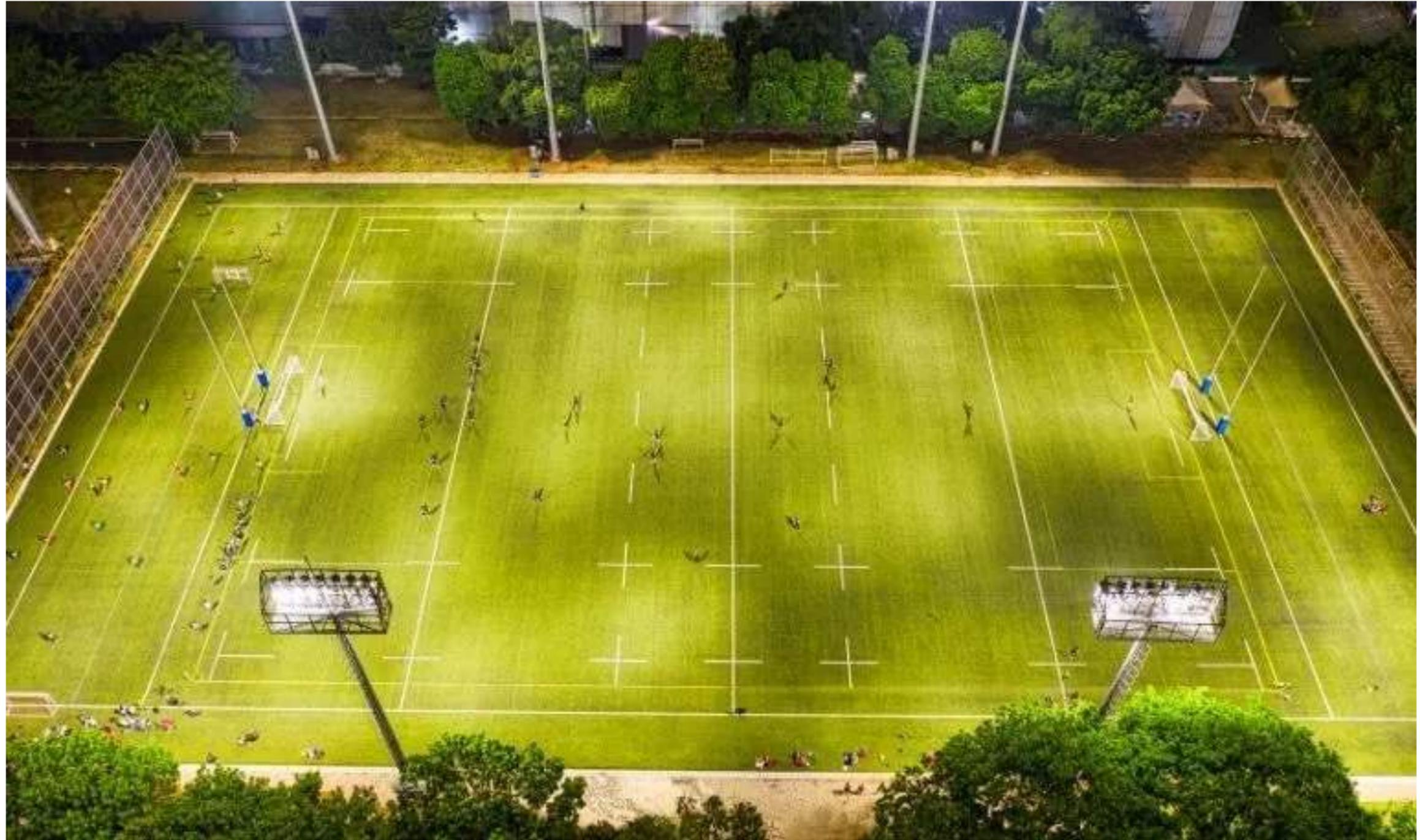
Se requiere un nivel adecuado de uniformidad para crear condiciones de iluminación equilibradas para que los ojos de las personas y las cámaras de televisión no tengan que adaptarse continuamente a un nivel de luz diferente.
