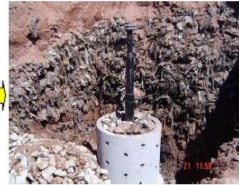
Instalación de nueva tubería de concreto y la cabeza
