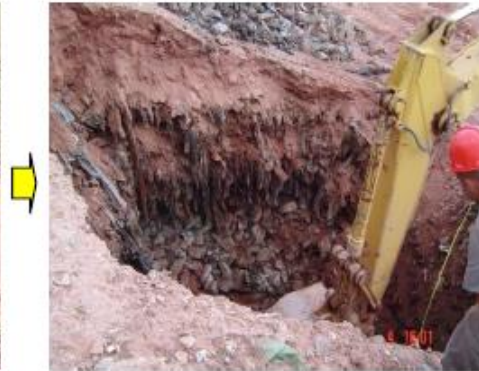
Excavación de 5 a 7 metros de profundidad
