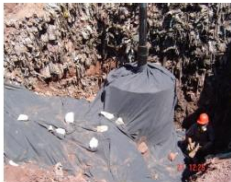
Interconexión y protección de los drenajes con geotextil
