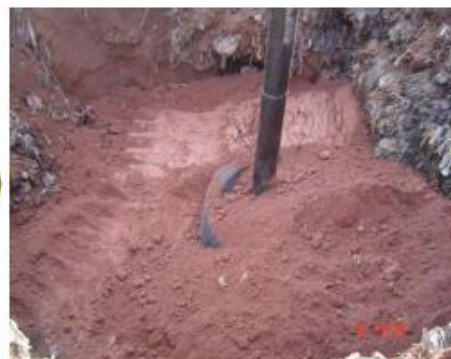
Relleno con suelo compactado - sellado
