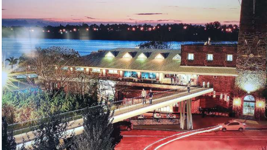
Figura 14 - Puente de acceso peatonal al Club Remeros.
