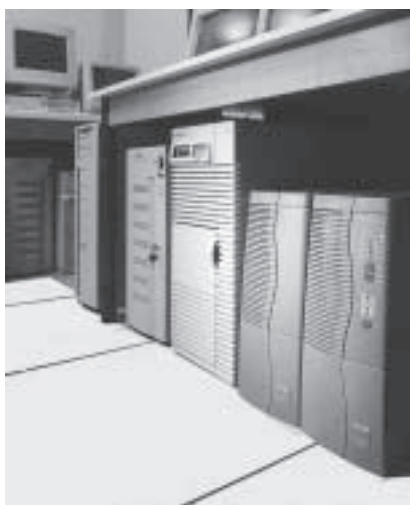
Fig. N30b: Unidad SAI logrando disponibilidad y calidad del suministro eléctrico del sistema informático.
