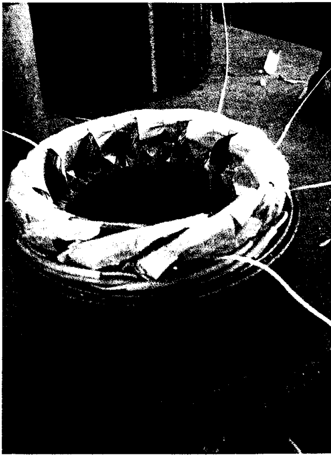
Fig. 9.48. Motor con aislamiento entre grupos de bobinas (cortesía de Electro-Utrera).
