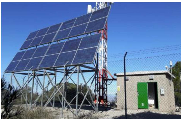
Instalación fotovoltaica aislada con baterías de plomo ácido, “Hybrid and Intelligent Energy Storage Systems in Standalone Photovoltaic Applications”, Iván Sanz PhD dissertation
