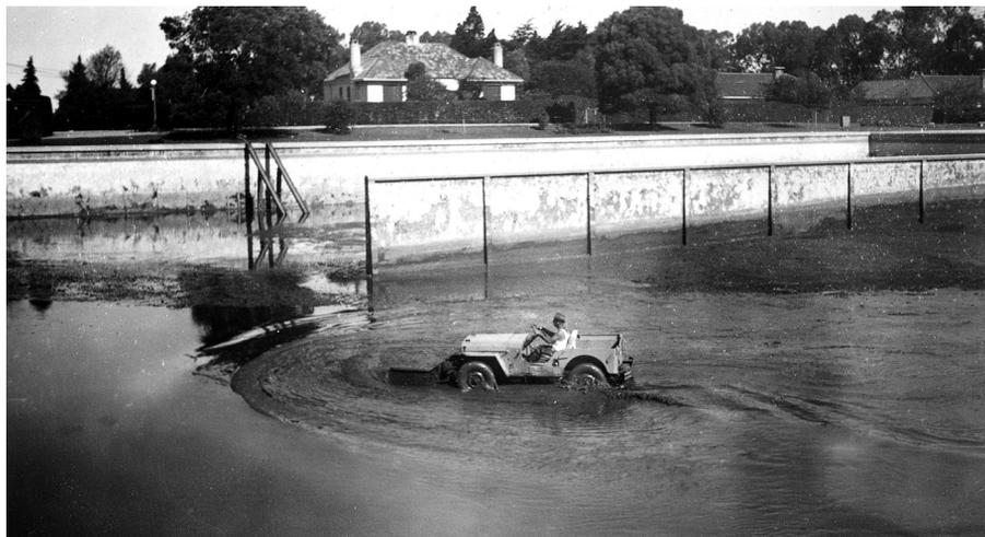
Limpieza en vehículo del residuo de la sedimentación en la pileta de decantación N° 6. Planta de Aguas Corrientes, abril de 1948.
