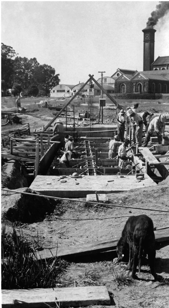
Construcción de la nueva toma y túnel de 1,20 m de diámetro.
