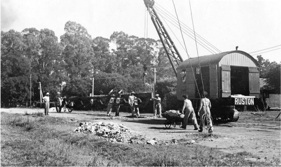
Traslado de viga metálica para obras en Sala Diésel.
