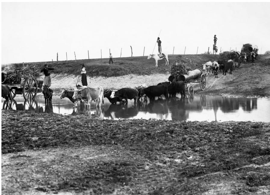
Traslado de caños para la instalación de la primera tubería de bombeo. Año 1869.
