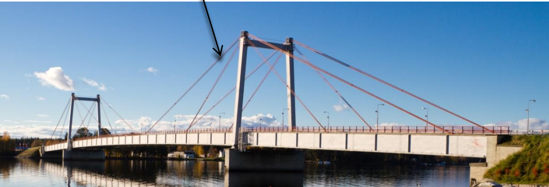
Strömsund Bridge (F. Dischinger, 1955)
