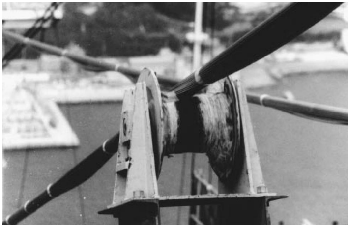
Cordones prefabricados de alambres paralelos (4000 m) Puente Akashi Kaikyo
