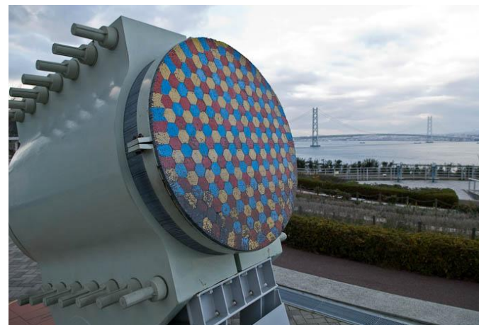
Cordones prefabricados de alambres paralelos (4000 m) Puente Akashi Kaikyo
