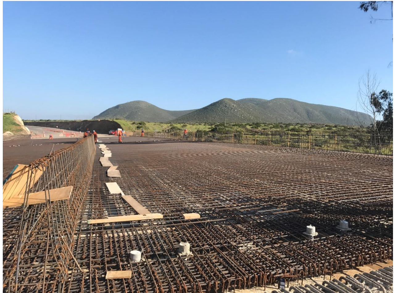
Puente La Laguna Ruta 43, IV Region
