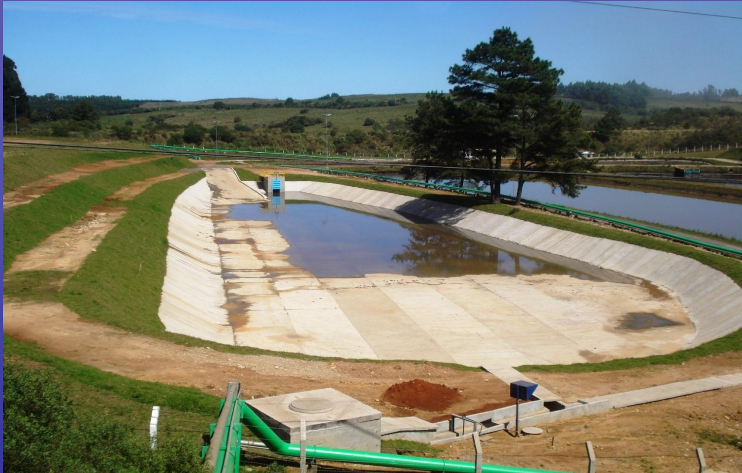
Bacia de emergência – acúmulo de água excepcionais
