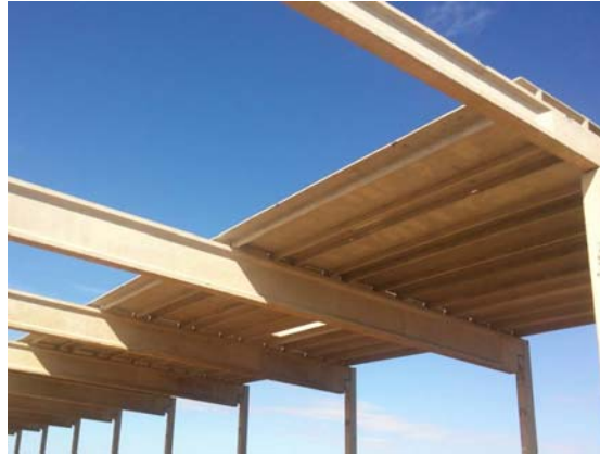
Figura 18: Edificación en fase constructiva
