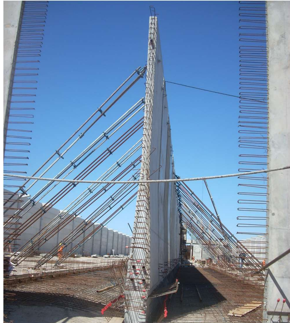
Losa de cimentación Complejo industrial Montes del Plata – Colonia
