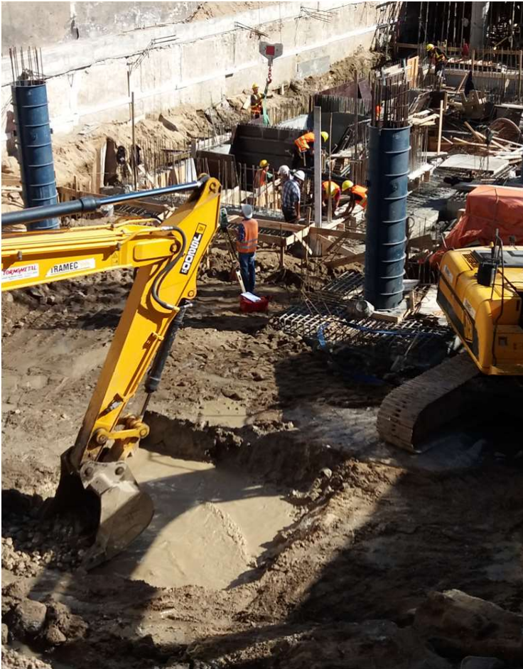
Ejecución de zapatas Edificio Rambla – Montevideo
