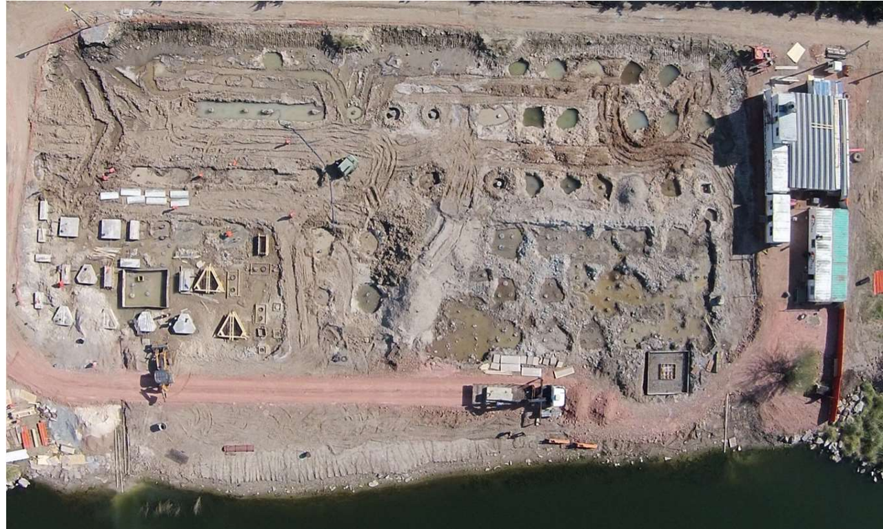
Ejecución de cimentación con pilotes Edificio Lago - Canelones
