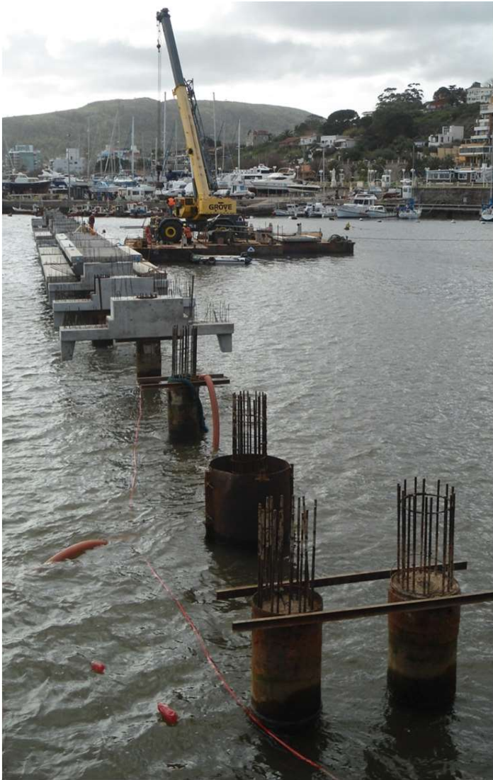
Ejecución de cimentación con pilotes Puerto de Piriápolis - Maldonado
