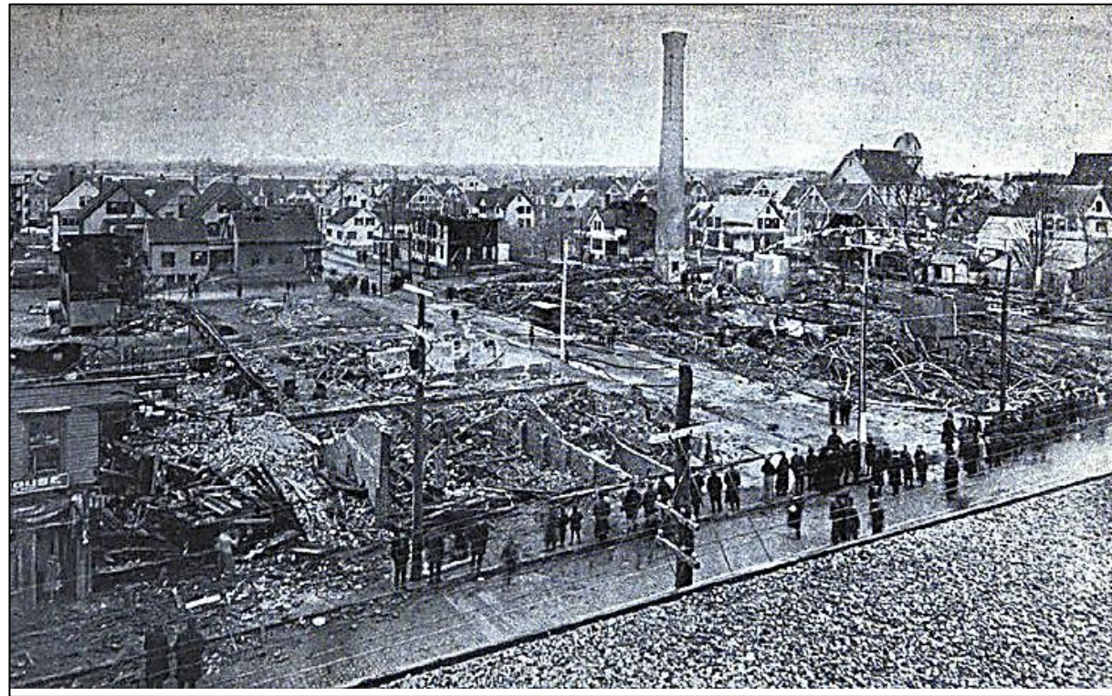
Fábrica de zapatos “RB Grover Company” después de la explosión
