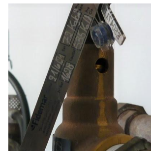
Placas de calibración de válvulas de seguridad. Autor: URSEA.
