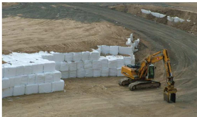
Figura 5-3: Compactador de residuos BOMAG BC-672 9 Figura 5-4: Relleno de fardos 10
