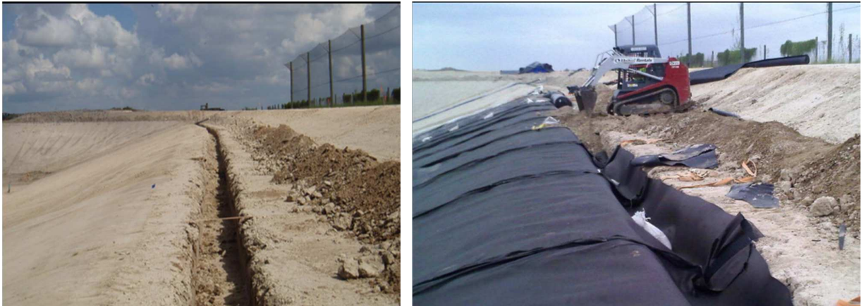
Figura 6-2: Zanja y relleno para el anclaje [2]
