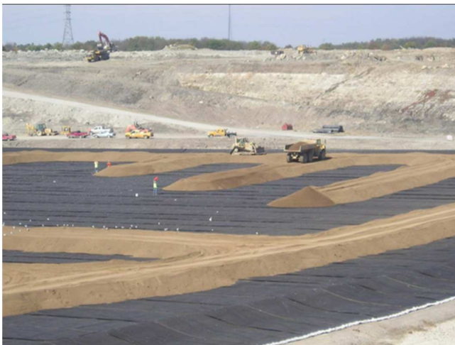
Figura 6-3: Distribución en dedos del material protector [2]
