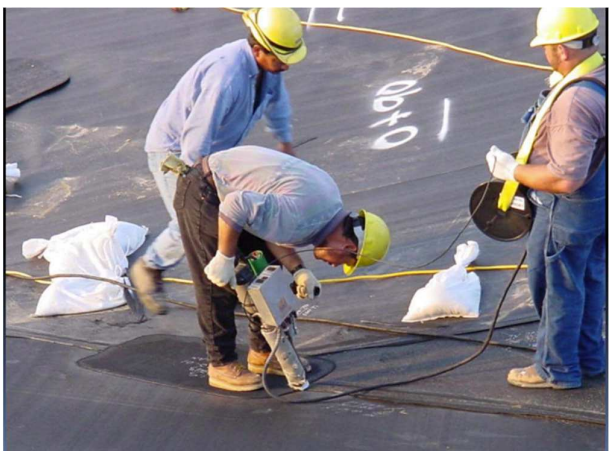
Soldadura por extrusión
