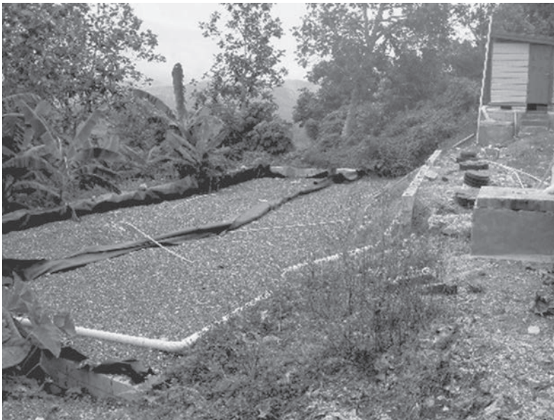
Figura 11.25 Humedal de flujo de subsuperficie (antes de la plantación de vegetación) que sirve a más de 200 estudiantes en la Escuela para todas las edades de Písgah (Jamaica) Los humedales de flujo de subsuperficie (SSF) típicamente utilizan grava como el medio de ruteo acuático de la planta, y el nivel del agua es intencionalmente mantenido por debajo de la superficie de la grava. Diversos regímenes hidráulicos pueden emplearse: flujo horizontal, flujo hacia arriba vertical y flujo hacia abajo vertical. Los tanques sépticos y los humedales tratan sólo aguas negras de los inodoros y no tratan aguas grises. El humedal tiene dos camas de medio de piedra paralelas delineadas en plástico (separadas por el plástico negro en el centro de la cama). Cada cama tiene dimensiones internas de 19.1 m de longitud por 4.7 m de ancho por 0.5 m de profundidad de medio. Los medios son piedras lavadas formadas irregularmente ordenadas como “guijarros de río de 1/2 pulgada” y el volumen de los rangos de piedra en tamaño de ¼ a 1 pulg (6-25 mm) de diámetro. La porosidad del medio fue medida en 37.7% sin raíces de planta.
