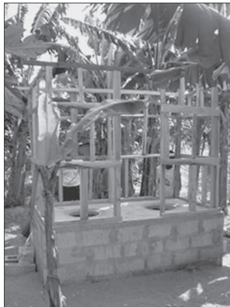
Figura 11.2 Letrina de composta de doble bóveda en construcción en Vanuatu Estas letrinas se pueden diseñar para separar orina y heces. La orina es enrutada a un pozo de jabón o recolectada en una olla o enrutada hacia un jardín y utilizada como fertilizante. Un lado de la letrina es utilizado por hasta 12 meses, mientras que el otro lado es composta. Los desecantes como la madera de fresno y el aserrín son añadidos para reducir olores y matar patógenos. El cobertizo de privacidad se construye de madera local y materiales tejidos de planta. Las letrinas de composta no requieren adición de agua, a diferencia de otras tecnologías de saneamiento, y permiten que los nutrientes se utilicen en forma local.
