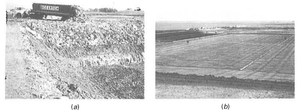
FIGURA 11.8 Vistas de la construcción de diferentes tipos de vertederos: (a) vertedero de celda excavada y (b) vertedero en zona.
