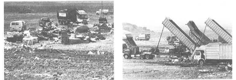
FIGURA 11.1 Vistas de un vertedero funcionando.
