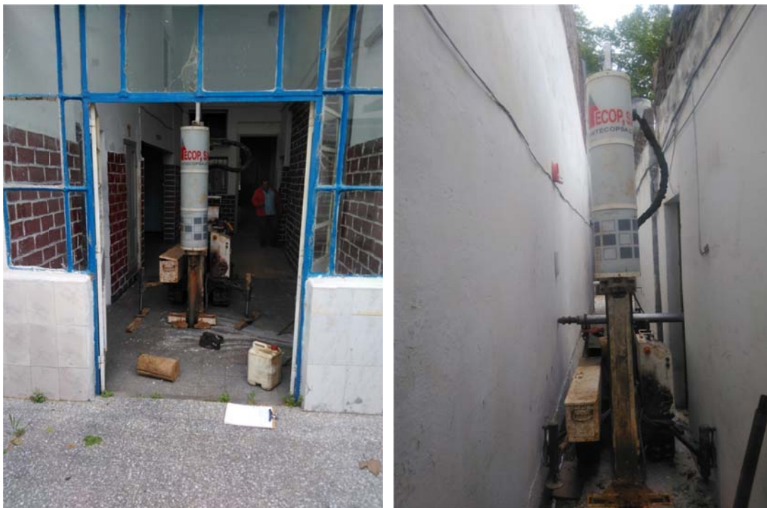
Figura 2. Equipo de perforación utilizado
