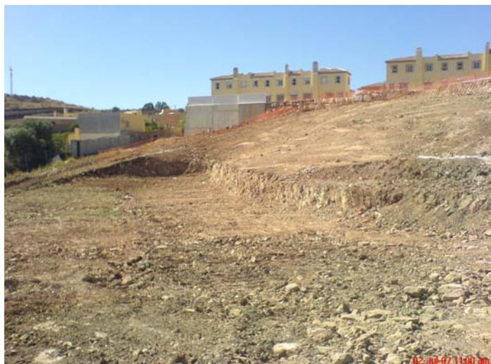
Terreno de rocas duras: terreno en el que es imprescindible utilizar martillos rompedores, explosivos u otras técnicas para romper las rocas, previamente a la excavación.
