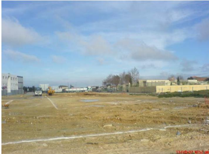
En la fotografía que aparece a la derecha, encontramos una explanada en la que se encuentra replanteado el cajeadado que se va a realizar para acometer la cimentación por losa que sustentará al edificio.
