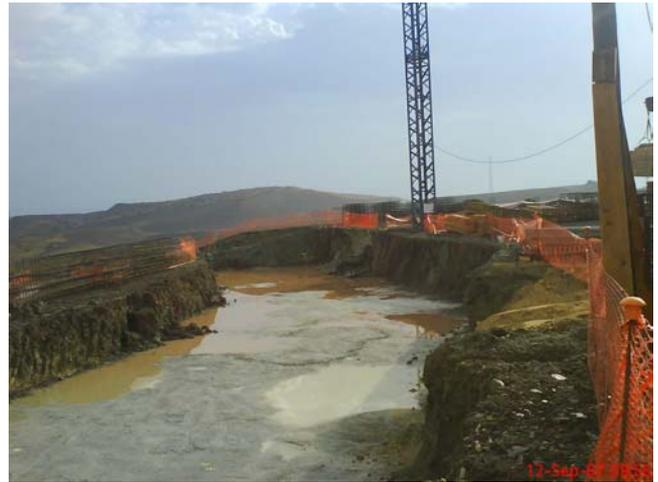
Terrenos blandos, limos, arenas: terreno cuya excavación se realiza con facilidad
