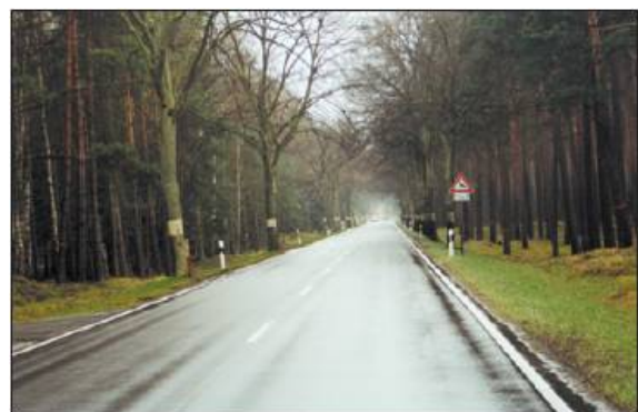
Figura 2.19 Mala transición en curva horizontal
