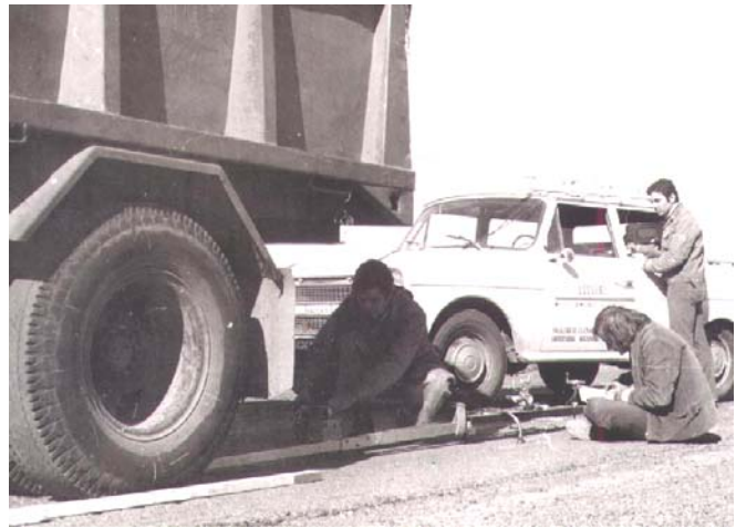
Fig. 16 Medición con Regla Benkelman
