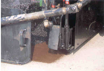
T11 CAPA DE ADHERENCIA o RIEGO DE LIGA imæ
