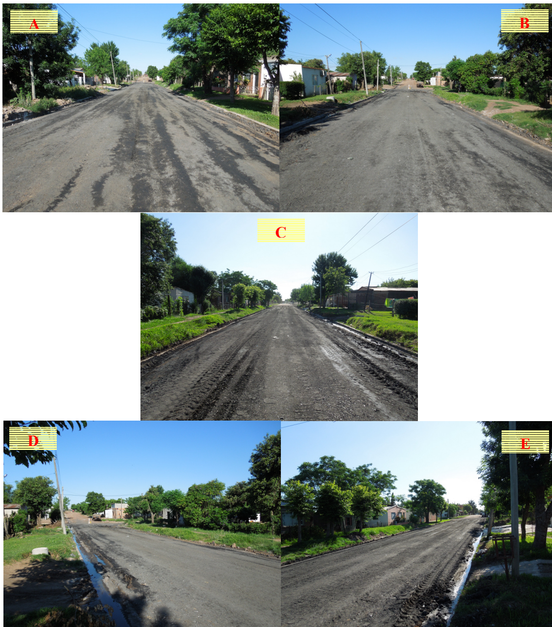
Figura 4.10. Condición Funcional del Tramo Experimental de la Calle Melo de Bella Unión Inmediatamente Después de su Construcción
