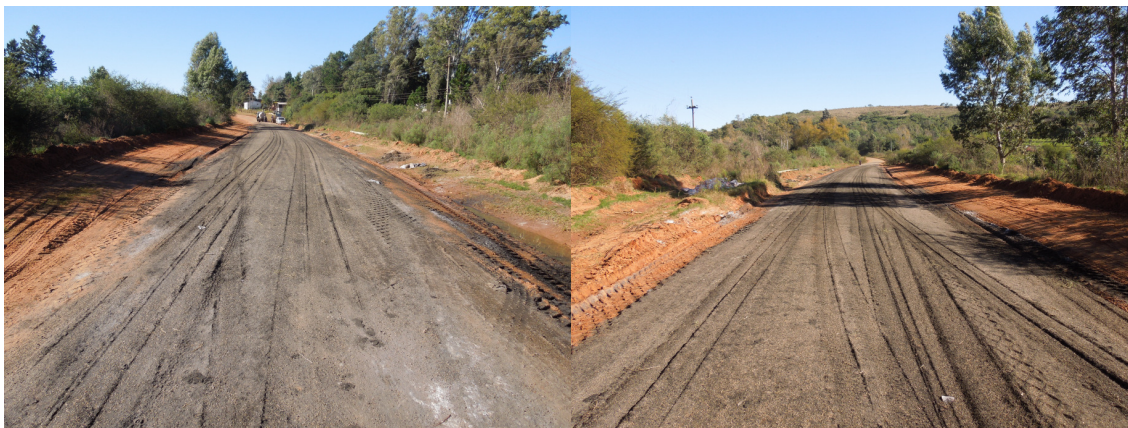
Figura 5.11. Condición del Tramo Experimental Unicapa del Camino a la Piedra Pintada al Finalizar la Obra de Construcción
