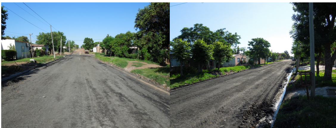
Figura 4.9. Condición al Final de Obra del Tramo Experimental de la Calle Melo de Bella Unión
