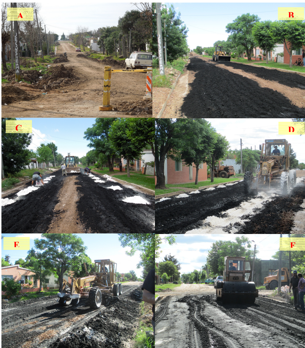
Figura 4.8. Etapas de Construcción del Tramo Experimental de la Calle Melo de Bella Unión
