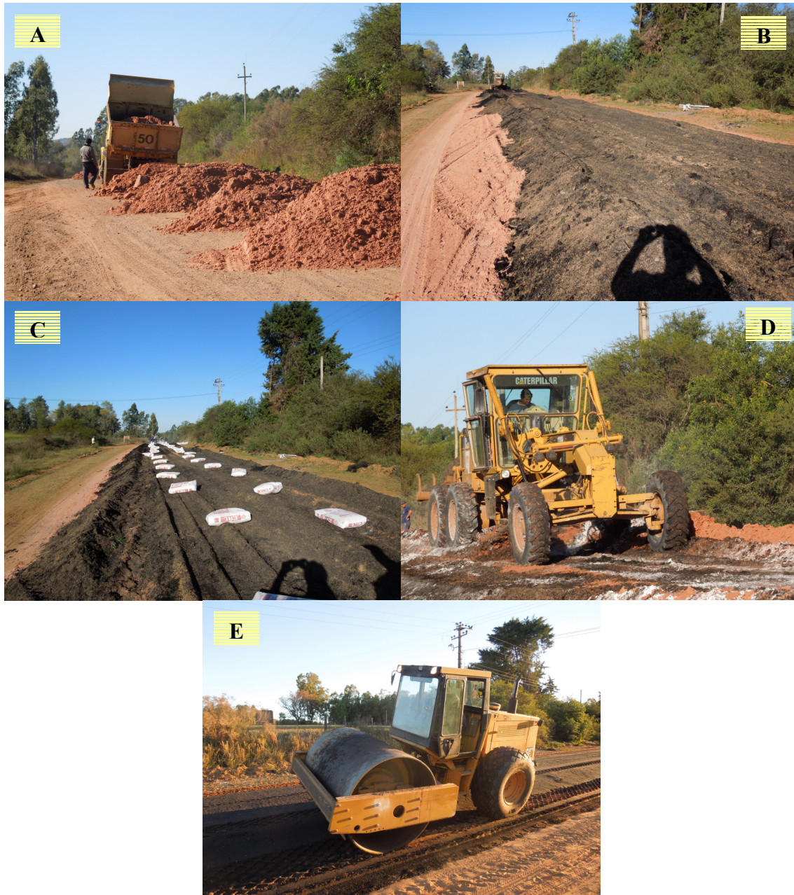
Figura 5.12. Etapas de Construcción del Tramo Experimental con Capa de Recargo del Camino a la Piedra Pintada
