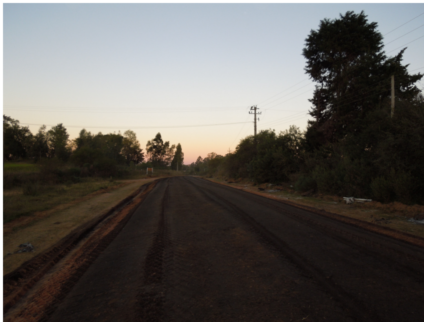
Figura 5.13. Condición del Tramo Experimental con Capa de Recargo del Camino a la Piedra Pintada al Finalizar la Obra de Construcción
