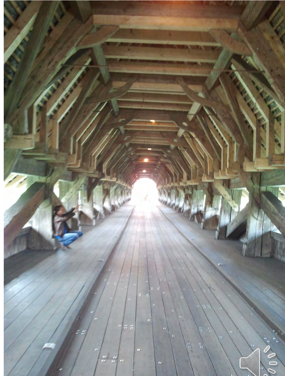
Puente cubierto Thurbrücke (año 1815), Suiza
