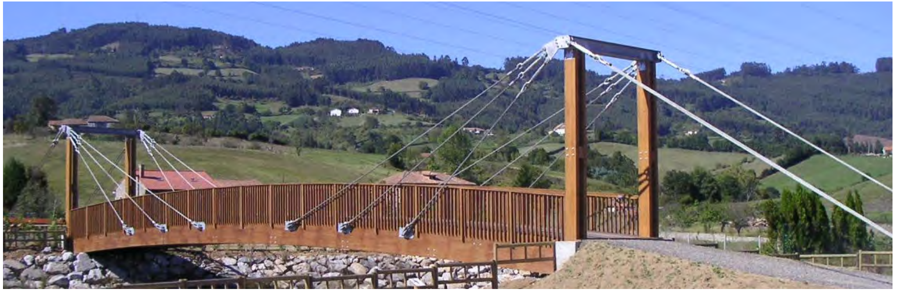
a) Puente 34X3,5m
