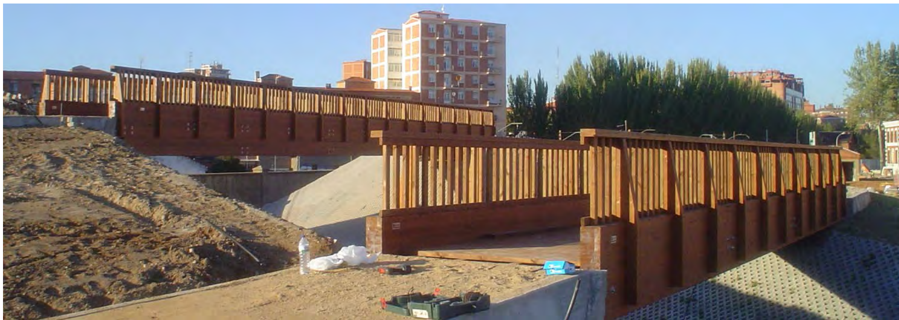
a) Puente 23x2m Valladolid
