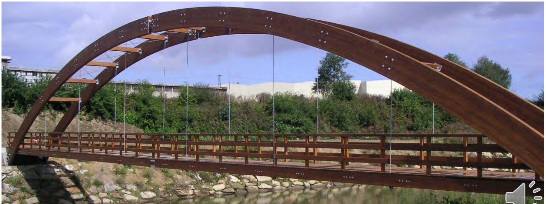
a) Puente 39x2m
