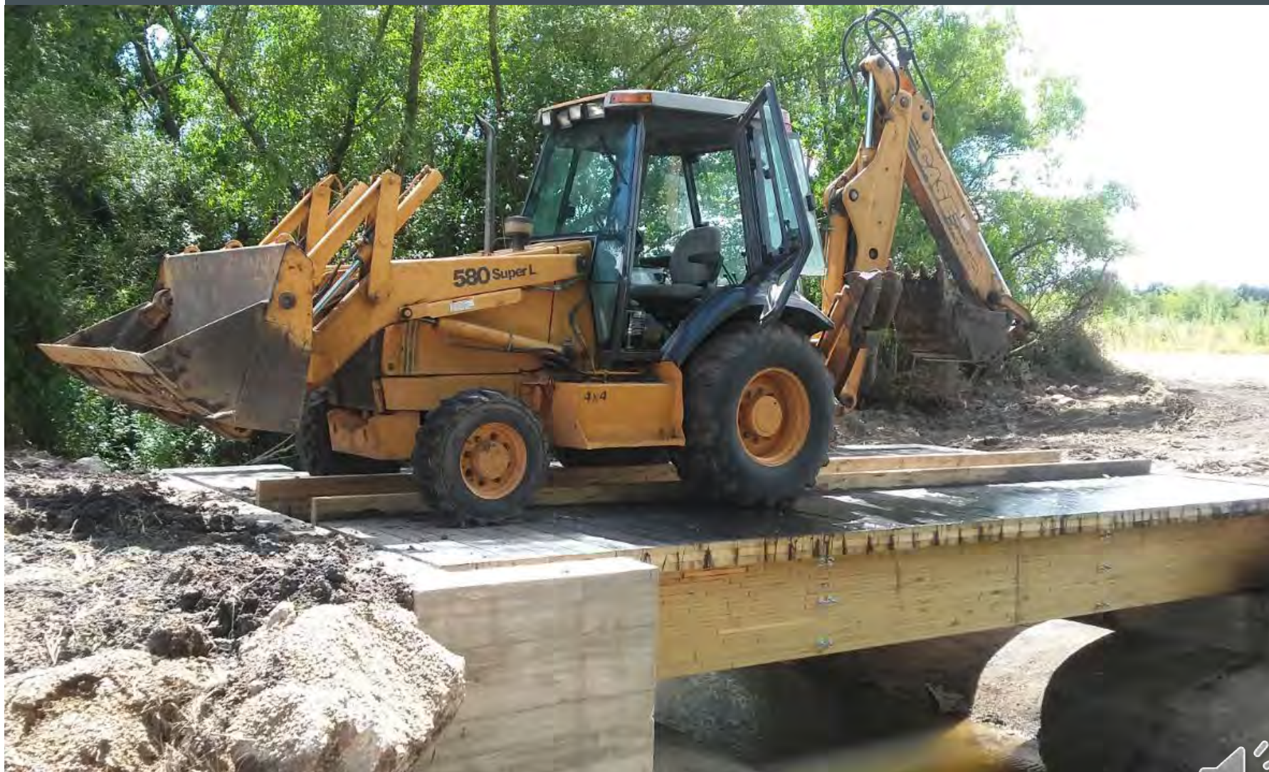
Fabricación de un prototipo de puente vehicular a partir del desarrollo de productos de ingeniería de madera de pino uruguayo
