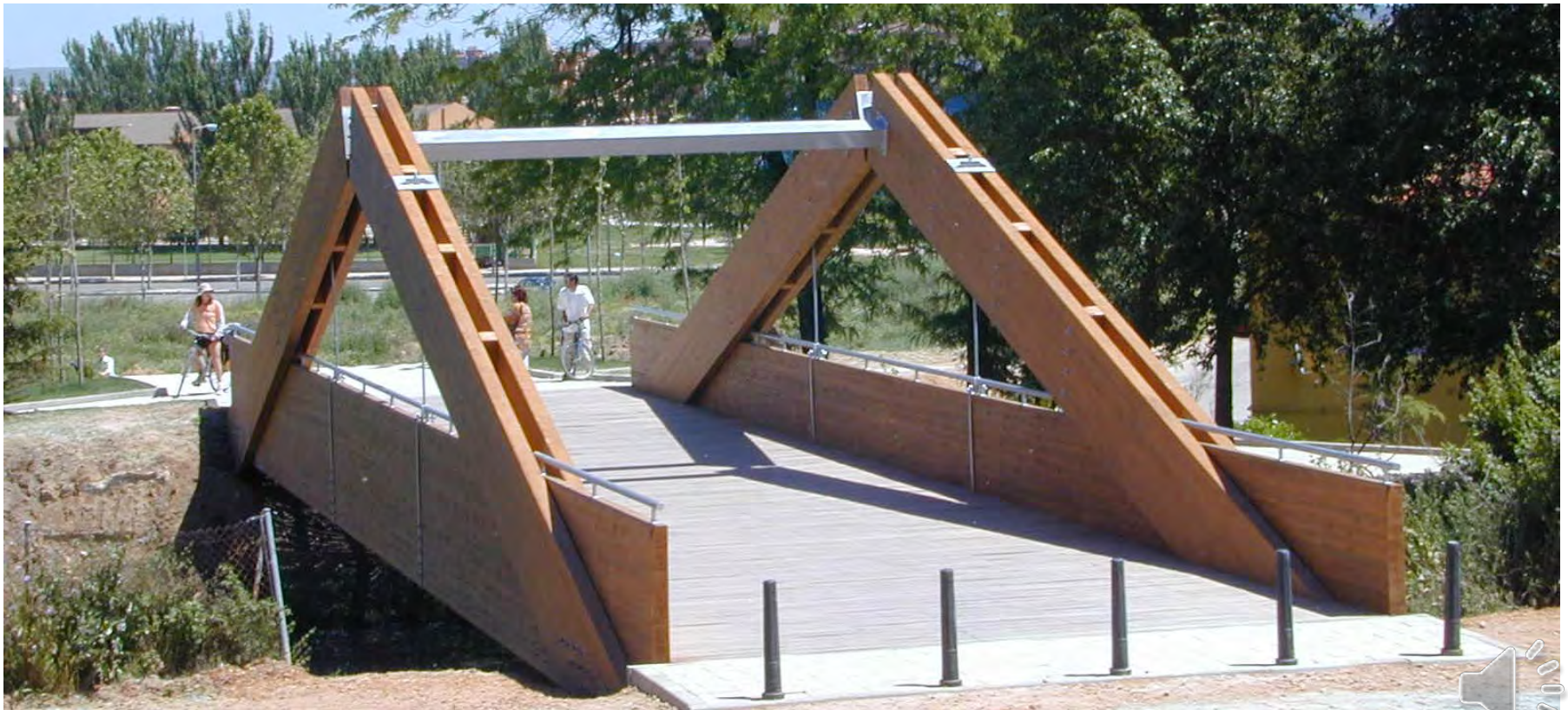
a) Puente 26x6m
