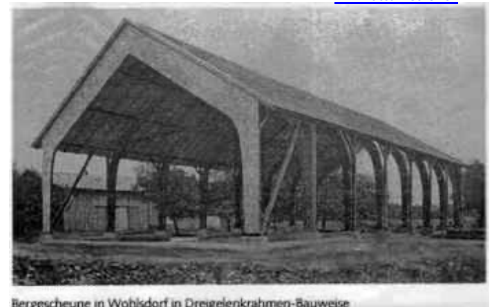
Bergscheune in Wohldorf in Dreigelenkrahn-Bauweise
