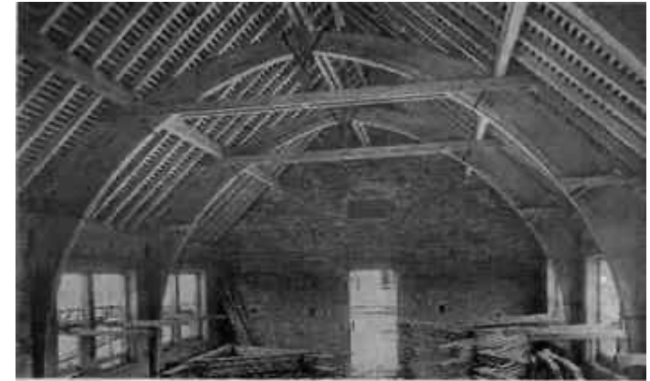
Rohbau der Turnhalle in Adliswil, Schweiz
