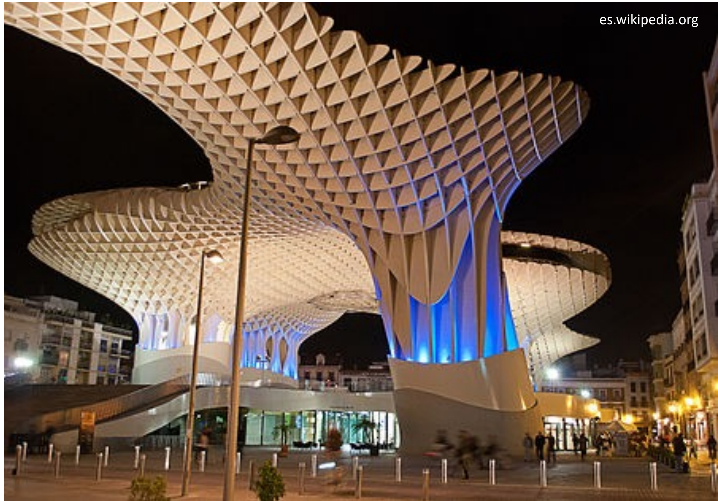
Metrosol-Parasol, Sevilla, España. Arq. J. Mayer H.+ Ing. ARUP+ Finnforest
