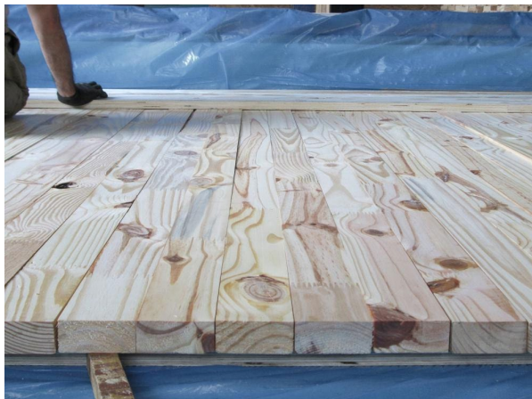
5. ARMADO DE LOS PANELES
