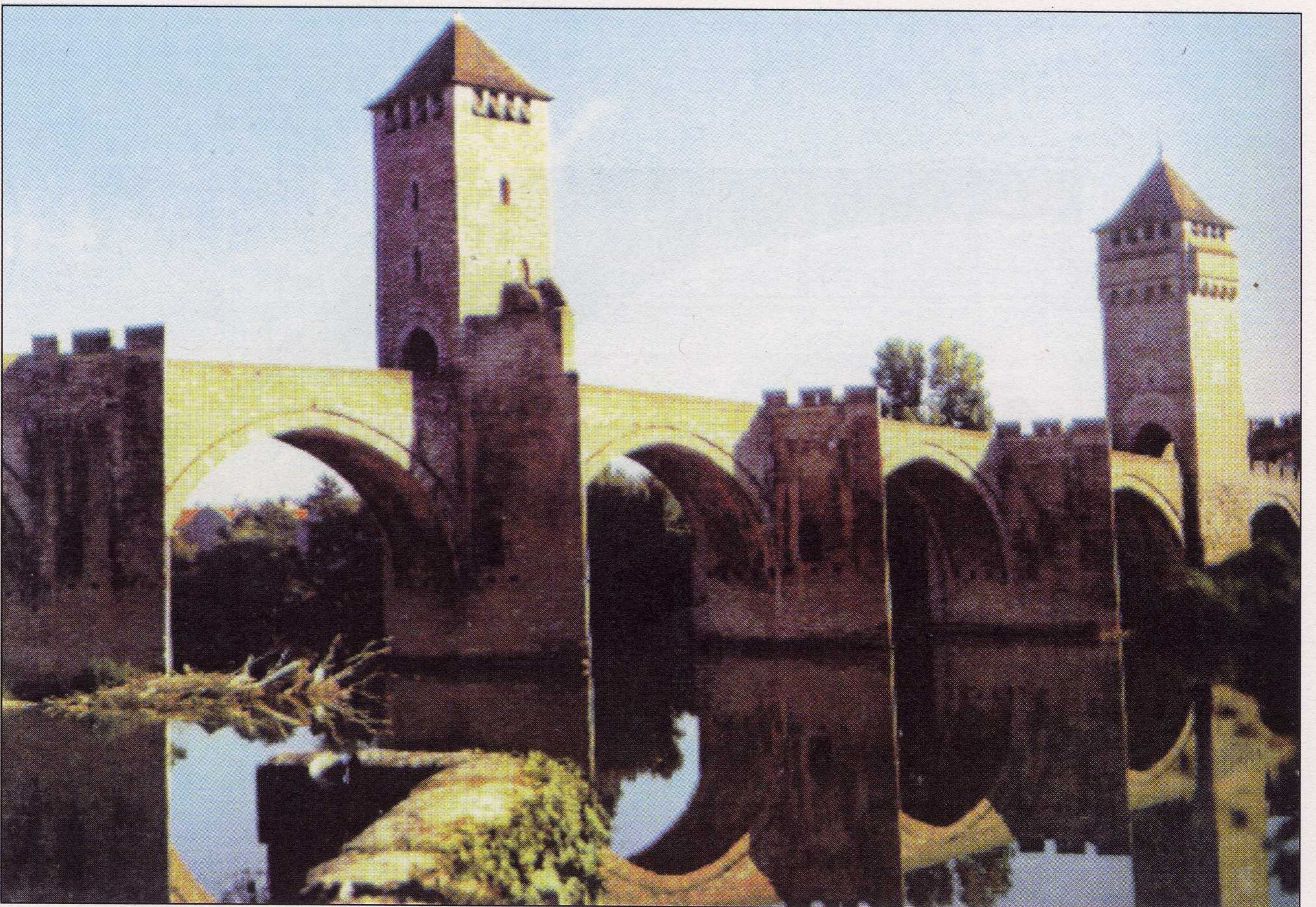
Figura 2.2 Puente medieval en Alemania
