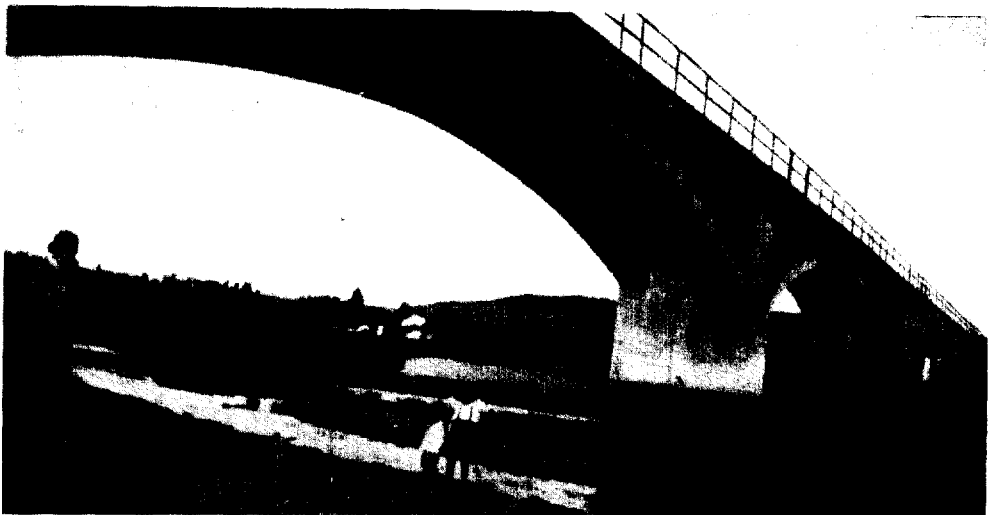
Figura 2.4 Puente sobre el Guadarrama (Eugenio Ribera)
