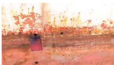
Figura 3 (estado no aceptable)
