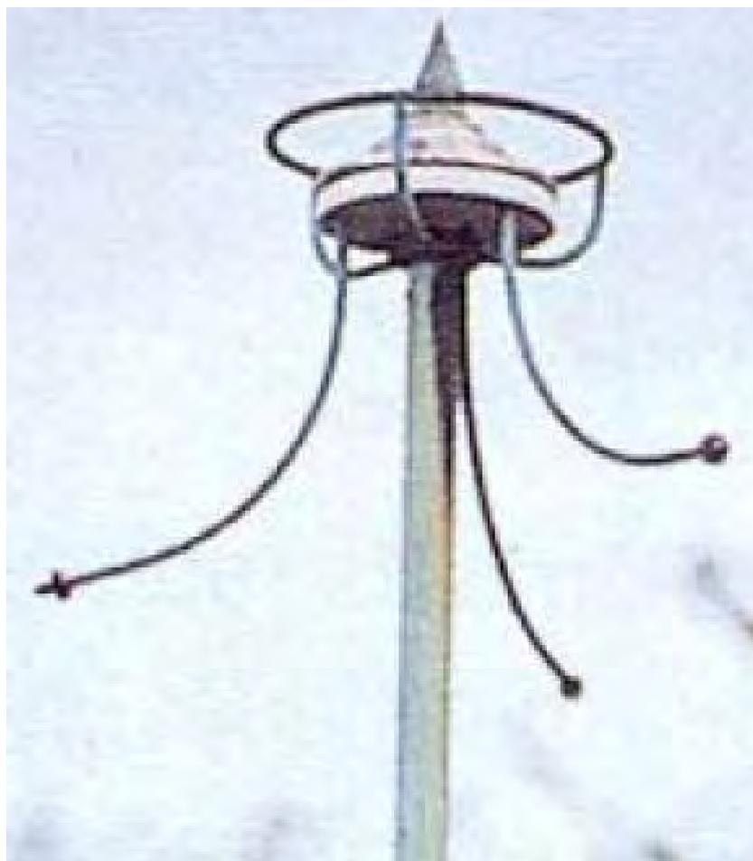
Figura 7.27: Pararrayos radiactivo. Cortesía de P. Gruet [50].
