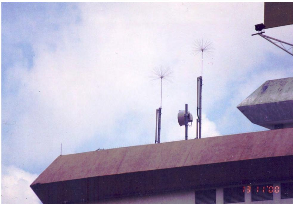
Figura 7.20: Disipadores esféricos. Cortesía de Hartono [32].
