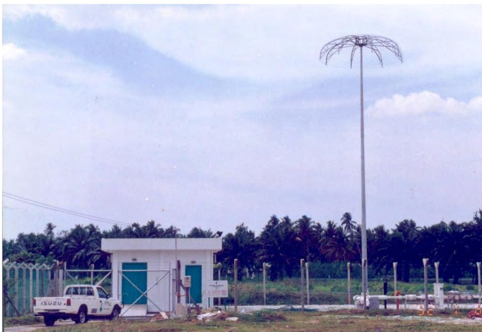
Figura 7.18: Disipador en forma de paraguas para protección de una instalación de gas. Cortesía de Hartono [32].
