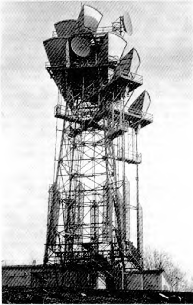
Figura 3 Una estación retransmisora (repetidora) de microondas, la cual recibe y luego retransmite señales que conducen las llamadas telefónicas a grandes distancias.
