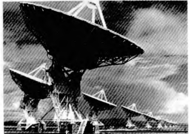
Figura 4 Uno de los 27 paraboloides radiotelescópicos, de 25 m de diámetro, en la Very Large Array , cerca de Socorro, Nuevo México. Los 27 paraboloides están dispuestos sobre una vía de rieles en forma de Y, cada uno de cuyos ramales tiene 10 millas de longitud. Esta disposición equivale a un solo plato de 20 millas de diámetro.
