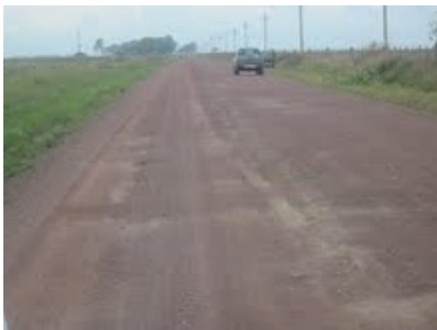
Figura 4.13. Desgaste superficial da camada de material residual de riolito no primeiro trecho experimental
