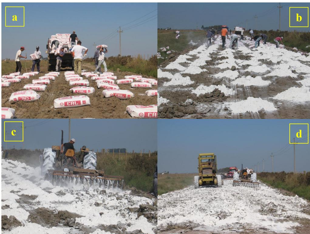
Figura 4.6. Operações de distribuição da cal e mistura ao solo. a) Colocação dos sacos de cal; b) Rasgado dos sacos de cal; c) Mistura da cal com o solo; d) Espalhamento da mistura do solo com a cal
