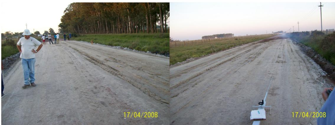
Figura 4.9. Condição superficial final de construção das camadas de solo-cal do primeiro trecho experimental
