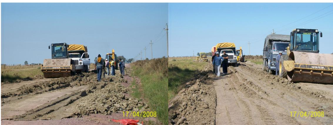
Figura 4.8. Compactação das camadas de solo-cal
