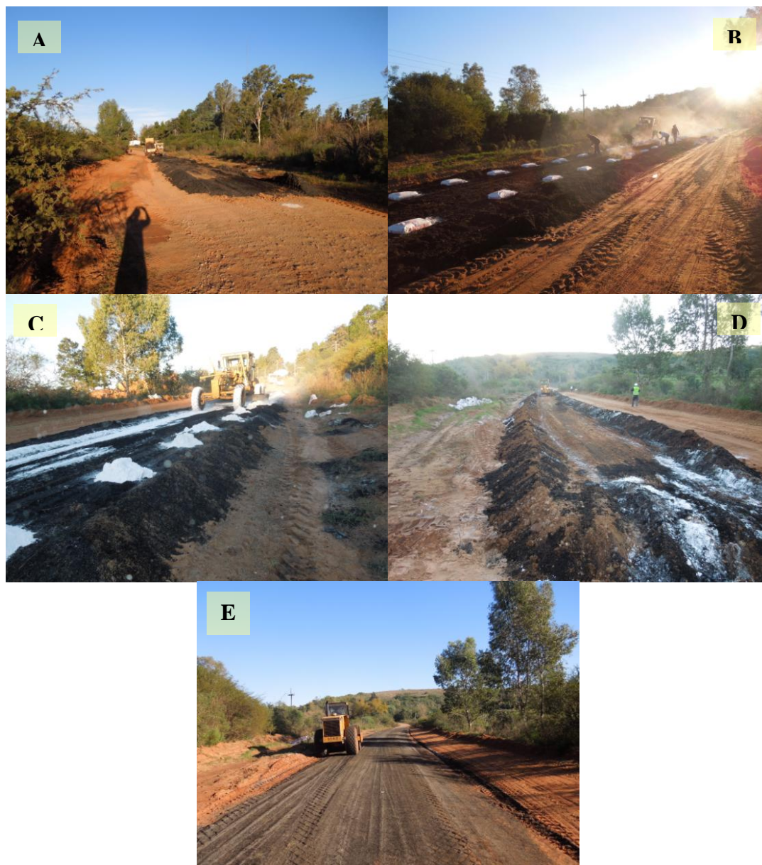
Figura 5.10. Etapas de Construcción del Tramo Experimental Unicapa del Camino a la Piedra Pintada
