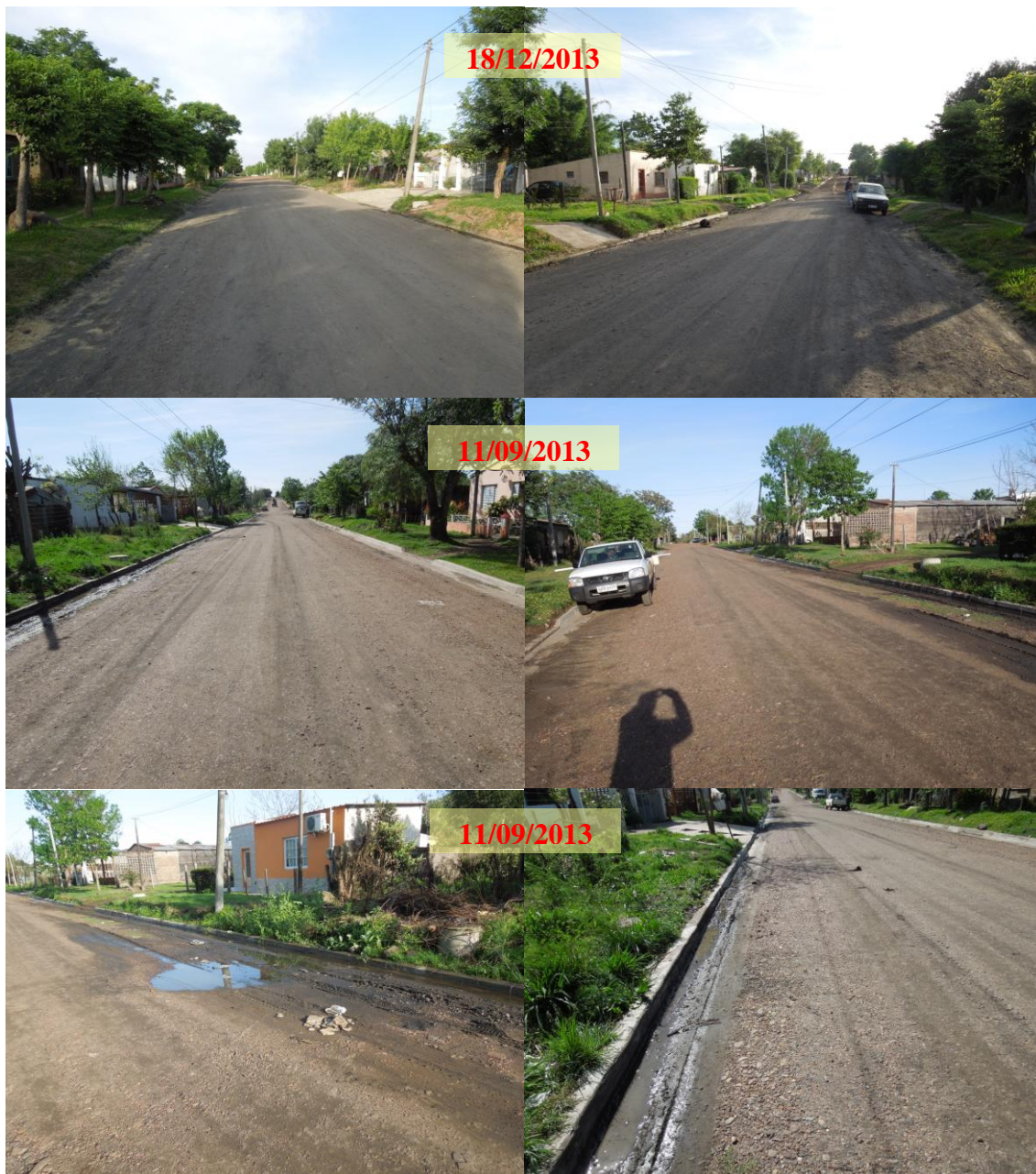
Figura 4.11. Condición Funcional del Tramo Experimental de la Calle Melo de Bella Unión en los Monitoreos Posteriores a su Construcción
