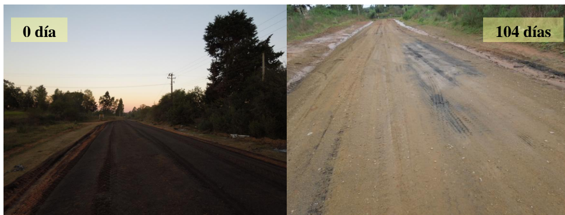
Figura 5.16. Condición Funcional del Tramo Experimental con Capa de Recargo del Camino a la Piedra Pintada a 0 día y 104 Días de su Construcción
