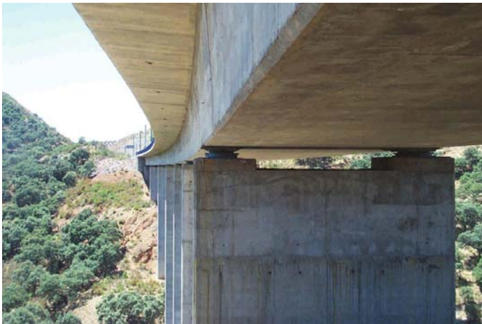
Puente en la línea ferroviaria AVE Madrid – Barcelona
