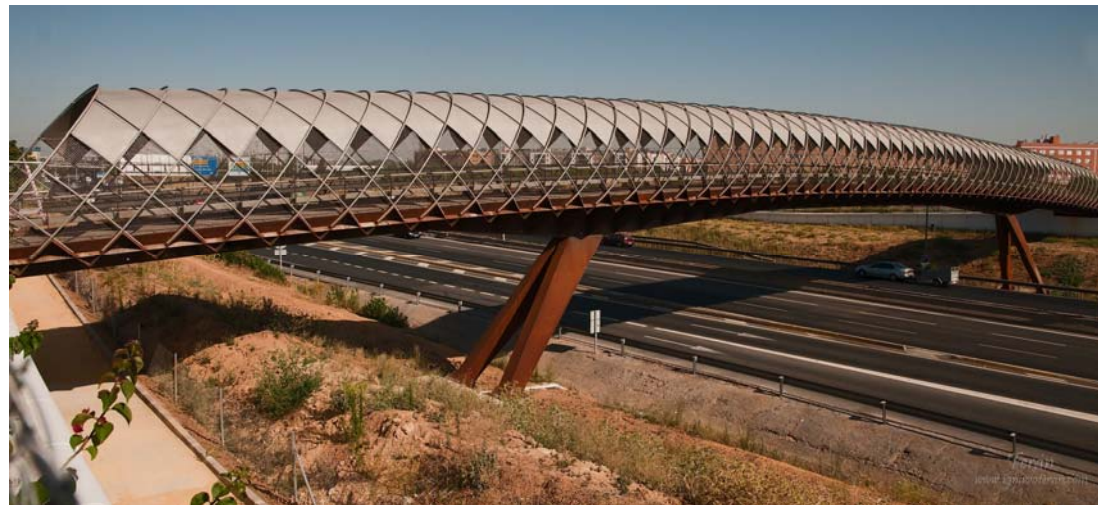
Pasarela sobre autopista SE30 en Sevilla, España.
