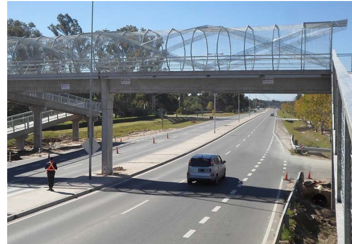
Pasarela Santa Ana en Ruta 5 de Argentina.
