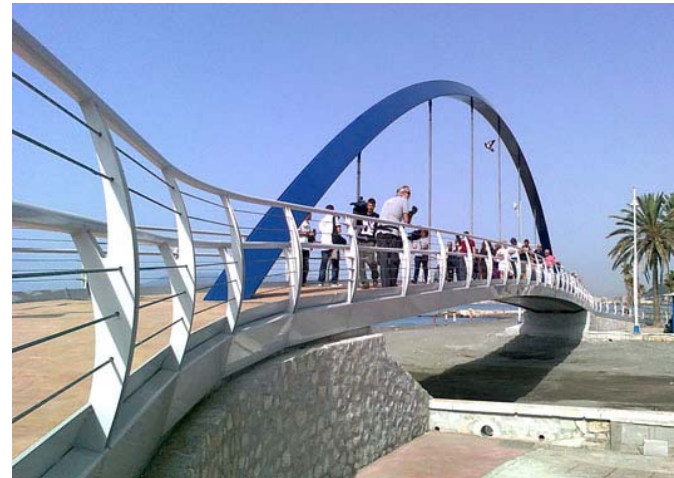
Pasarela de los Jabegotes en Malaga, España.
