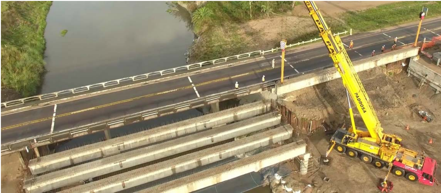
Colocación de vigas prefabricadas en el nuevo puente sobre el Canal Andreoni en la Ruta 9.
