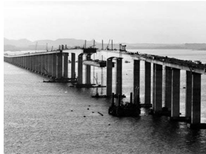
Levantamiento de vigas prefabricadas en el puente Presidente Costa e Silva que une Río de Janeiro y Niteroi.
