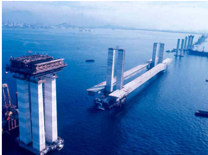
Levantamiento de vigas prefabricadas en el puente Presidente Costa e Silva que une Río de Janeiro y Niteroi.
