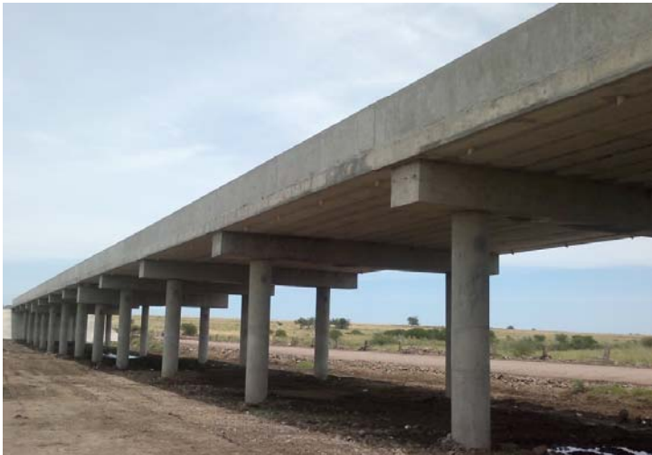
Puente Sangrador del Yucutujá en Ruta 30.
