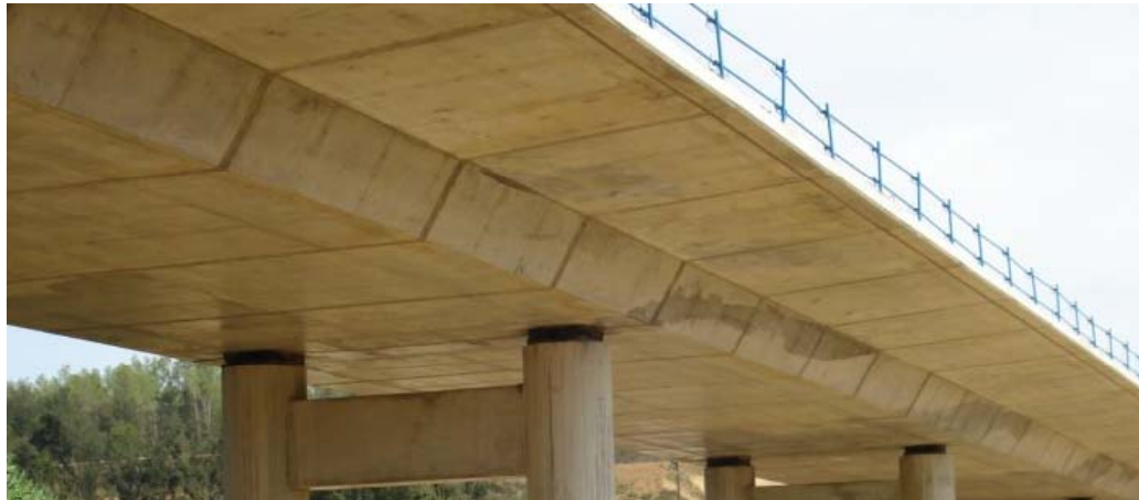
Puente de sección transversal maciza.
