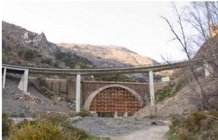
Puente de Bayacas sobre el río Chico en Granada, España. Es una estructura hiperestática de 3 vanos con luces de 27 m - 38 m - 27 m y 10 m de ancho. Está conformado por una losa pretensada de 1.30 m de espesor en su zona central con aligeramientos cuadrados y dos voladizos laterales de 2 metros de longitud.
