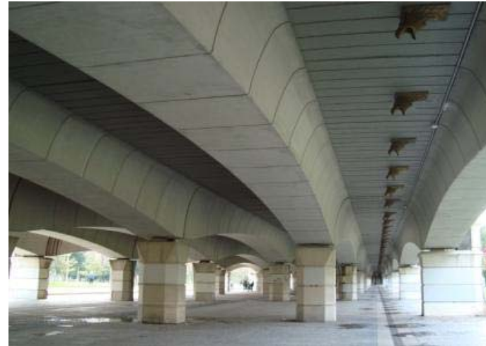
Desagüe del tablero de un viaducto
