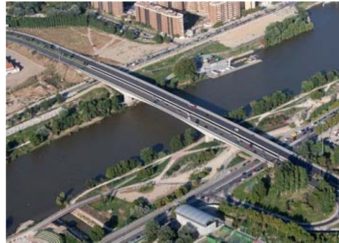
Puente recto de la Unión en Zaragoza, España.
