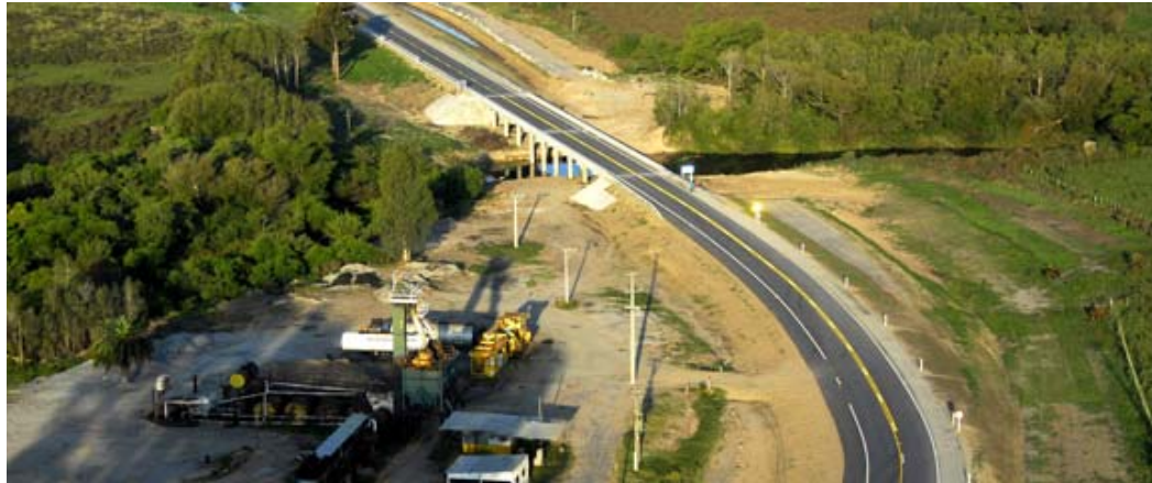
Puente sobre el arroyo Pando en ruta 11
