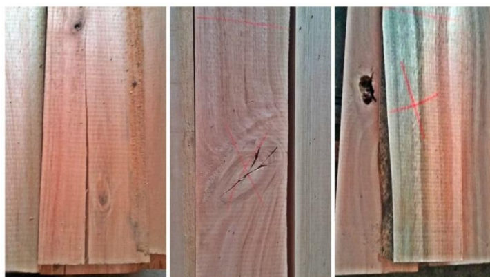
Figura 4.5: Singularidades características tablonces de Eucalyptus grandis a) fisuras pasantes, b) nudo; y c) arista faltante.
