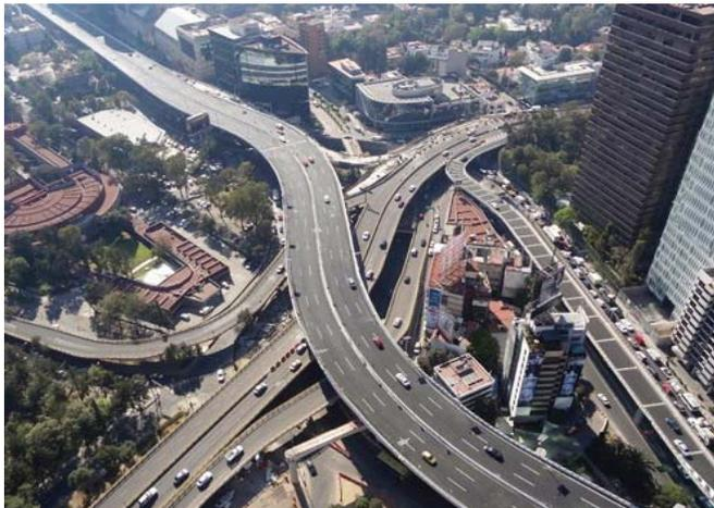
Los enlaces excesivamente complejos dificultan la disposición de los apoyos de las estructuras. Esto conlleva a un aumento de la luz de los vanos y/o vanos descompensados, implicando soluciones más caras.
