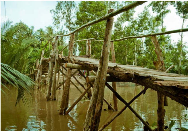
Puente de madera en Vietnam.
