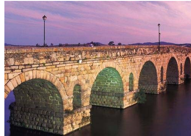
Puente de Mérida formado por 60 bóvedas de cañón y una longitud de 385 m.
