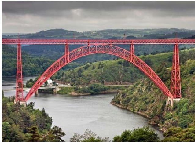
Viaducto de Garabit en Francia construido por Gustaff Eiffel en 1884. Presenta tablero superior.
