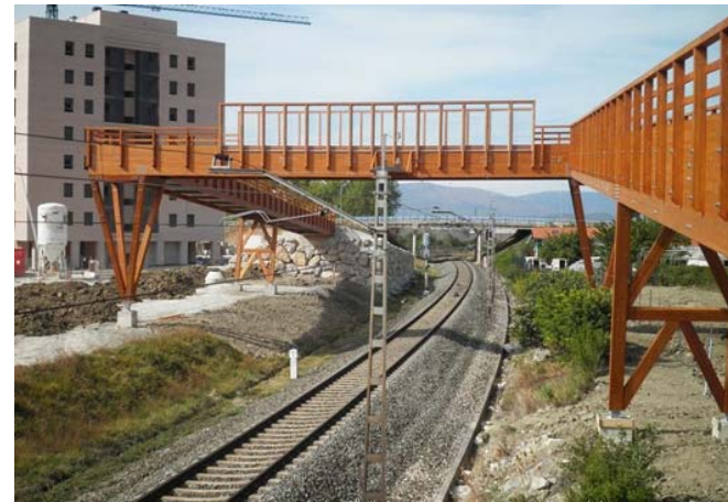
Pasarela peatonal en Navarra, España.
