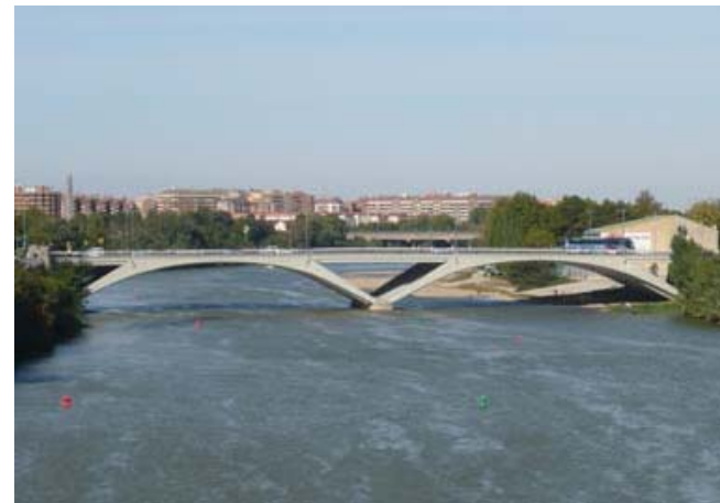
Puente de Santiago sobre el río Ebro en Zaragoza, España. Construido en 1967.
