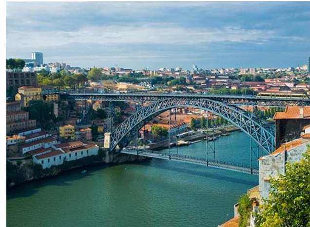
Puente de acero y tablero superior e inferior de Luis I en Porto, Portugal diseñado por Theophile Seyrig.
