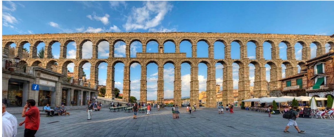
Arquería del acueducto de Segovia de finales del siglo I. Tiene 728 m y la altura máxima es de 30 m.
