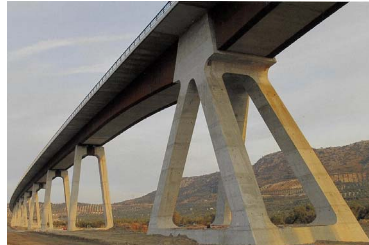
Viaducto ferroviario de Archidona en España.
