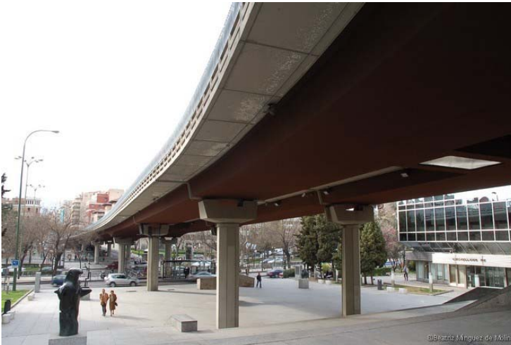
Viaducto en el Paseo de la Castellana en Madrid.
