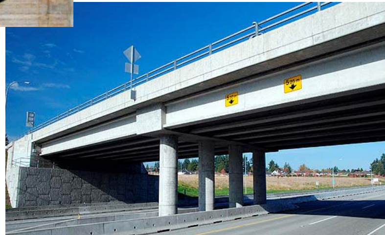
Puentes de hormigón pretensado.
