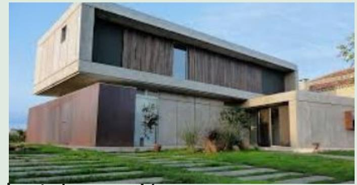
La formación de una capa de óxido protectora depende de las condiciones ambientales: acción del lavado de lluvia y secado del sol.
